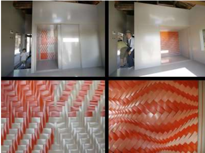
左壁の「閉じ網代」と「開き網代」。右壁の8段階グラデーションの漆を使った「波網代」
